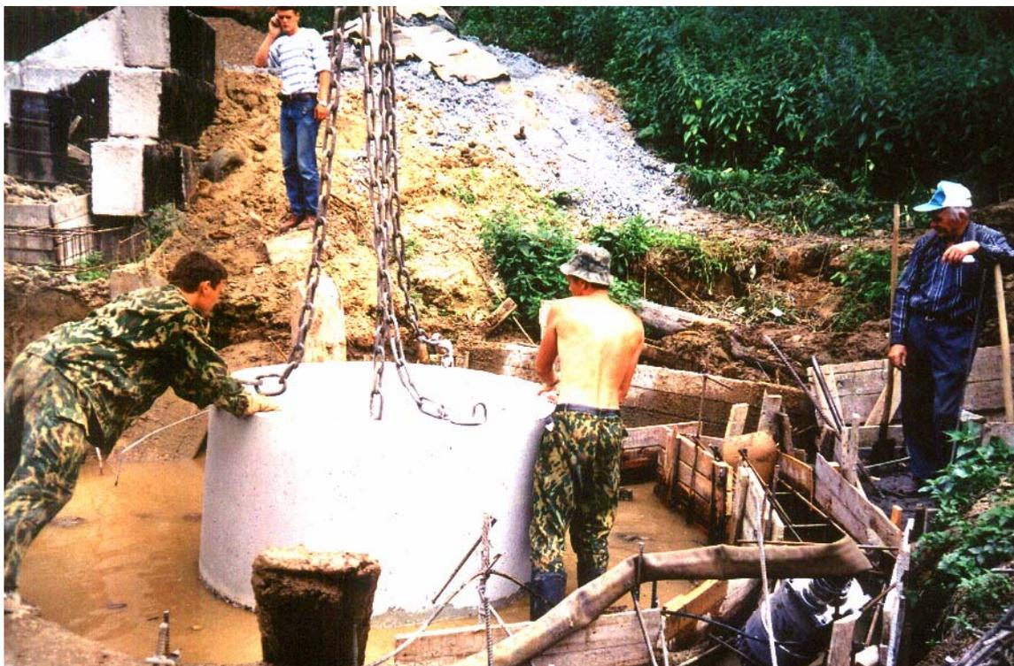
**Фото 5. Строительство каптажа ключа «Божья Роса». 2003г.**
